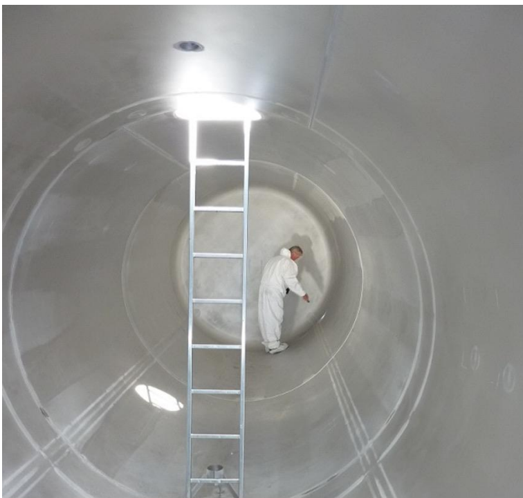
Bild 13: Renhetsgrad 3.2.x.x Tank av CrNiMo-stål utan missfärgningar
