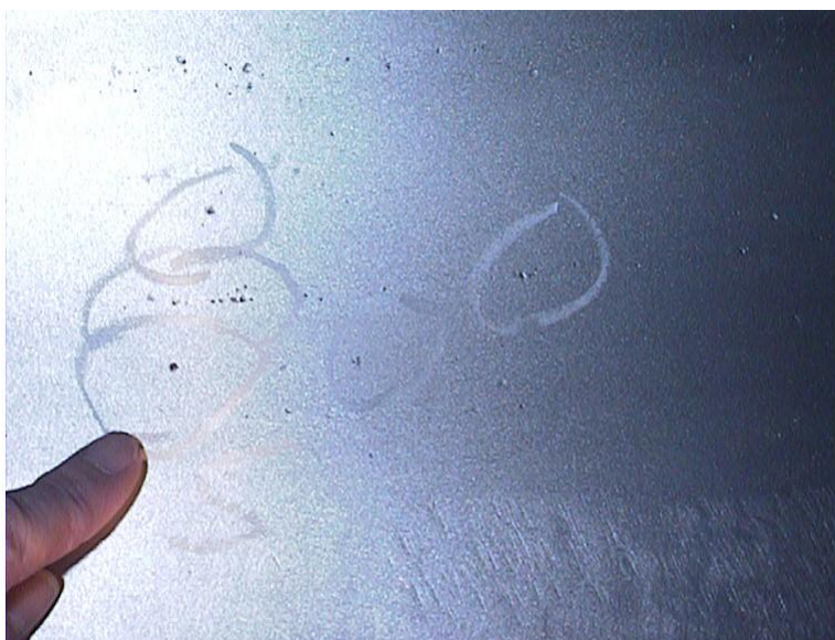
Bild 23: Renhetsgrad 3.6.x.x Hållkorrosion i väggarna
