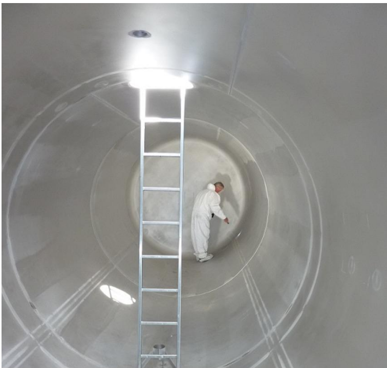
Afbeelding 13: Reinheidsgraad 3.2.x.x
