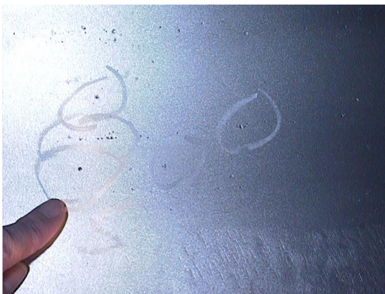
Figura 23: Grado de pureza 3.6.x.x Corrosión por picadura en la pared
